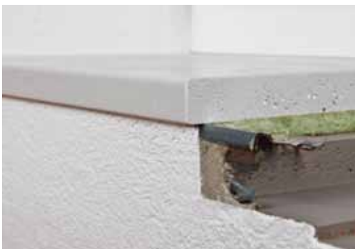
bündiger Einbau (mit Putzprofil)
