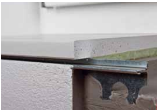
Einbau mit Schattennutprofil
