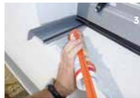
3. SlideAlu - L - Abschluss mit beiden mitgelieferten Schrauben am ebenen, mindestens 30 mm hohen Fensterbankanschlussprofil anschrauben.
