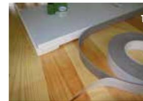
1. Vorkomprimiertes, selbststrückstellendes Fugendichtband BG1, 25/2-6 mm durchgehend auf Rückseite des kompletten Fensterbanksystems kleben. Beidseitig ca. 5 mm überstehen lassen.
