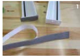
1. Vorkomprimiertes, selbststrückstellendes Fugendichtband BG1, 25/1,5-2,5 mm auf Rückseite des Anschraubsteges am SlideAlu Abschluss kleben. Beidseitig ca. 5 mm überstehen lassen.
