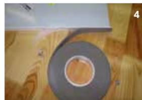
4. Vorkomprimiertes, selbststrückstellendes Fugendichtband BG1, 25/2-6 mm auf Rückseite des Anschraubsteges am SlideAlu Abschluss kleben.
