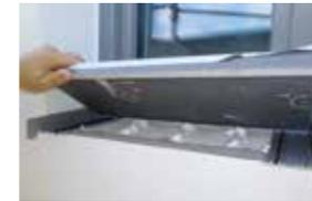
5. Die Fensterbank auf das fertig beschichtete (z. B. mittels Dichtschlemme) und nach außen geneigte Parapet versetzen. Befestigung erfolgt durch raupenförmig angeordnetem Montagekleber in Abständen von ca. 100 mm (in Neigungsrichtung). **Fuge zwischen Fensterbank und Parapet nicht abdichten!**
