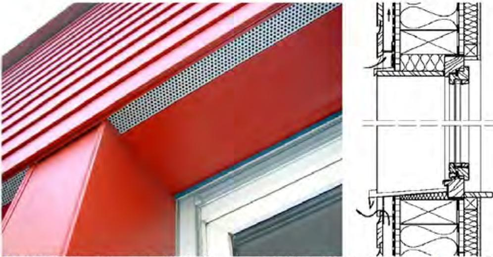
**Abbildung 32:** Zu- und Abluftöffnungen bei hinterlüfteter Fassade (Quelle: Fassaden aus Holz; Holzforschung Austria)
