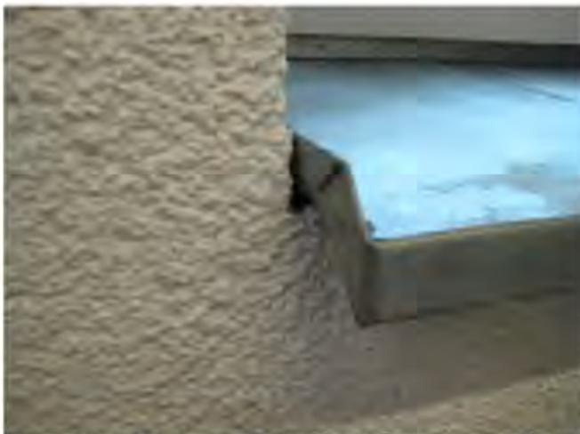
**Abbildung 31:** handwerklich gefertigte Fensterbank bei nachträglicher Montage (MW-N)
