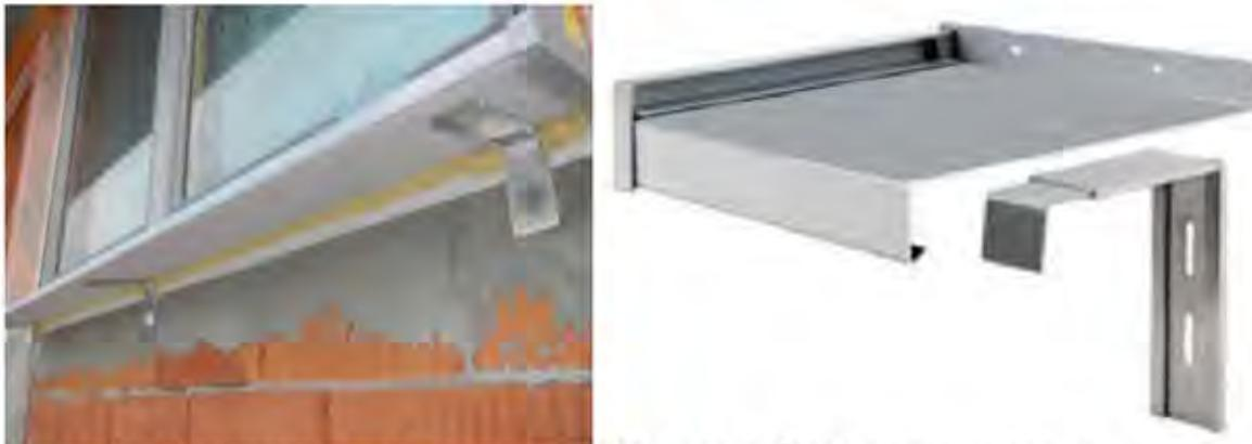
**Abbildung 8:** Fensterbank mit Fensterbankhalter; Beispiel eines Fensterbankhalters
