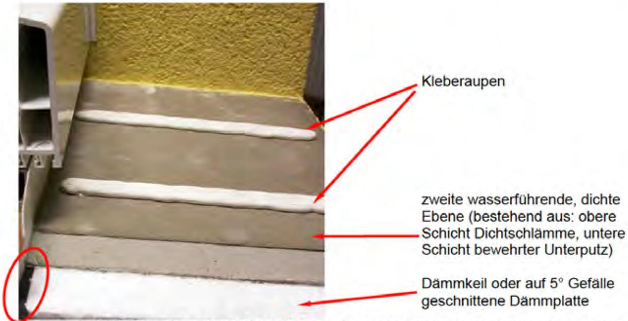
**Abbildung 10:** Kleberaupen auf zweiter Dichtungsebene, auf denen die Fensterbank verklebt wird. Die dabei entstehenden Hohlräume zwischen den Kleberaupen sind zulässig. Der Anschluss des Dämmstoffkeils / Fassadenplatte an das Fensterbankanschlussprofil erfolgt mittels Dichtband
