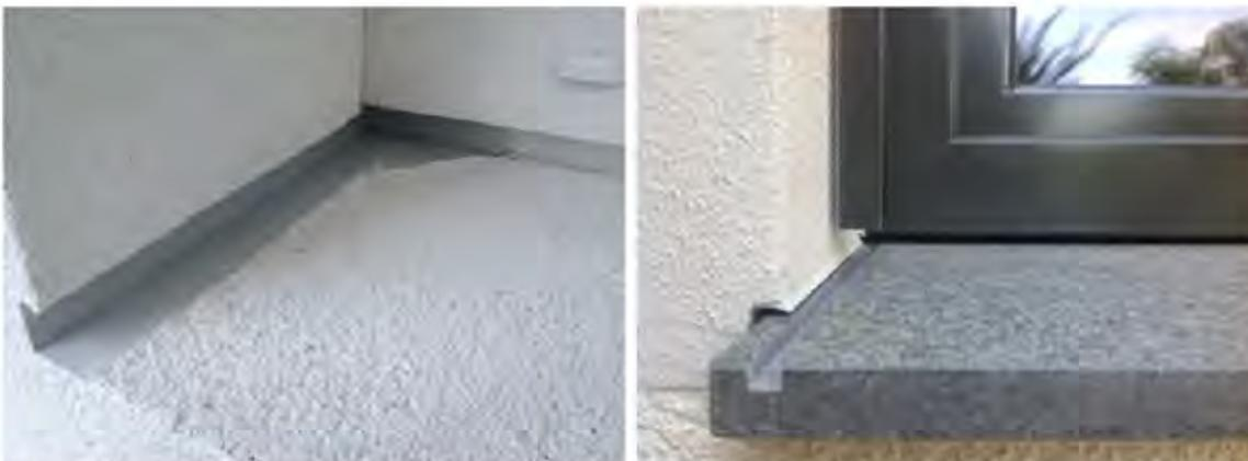
**Abbildung 29:** links: Putzprofil für eine Fensterbank-Montagevorbereitung mit einer zweiten zusätzlichen Dichtebene; rechts: mit später eingeschobener und montierter Steinfensterbank
