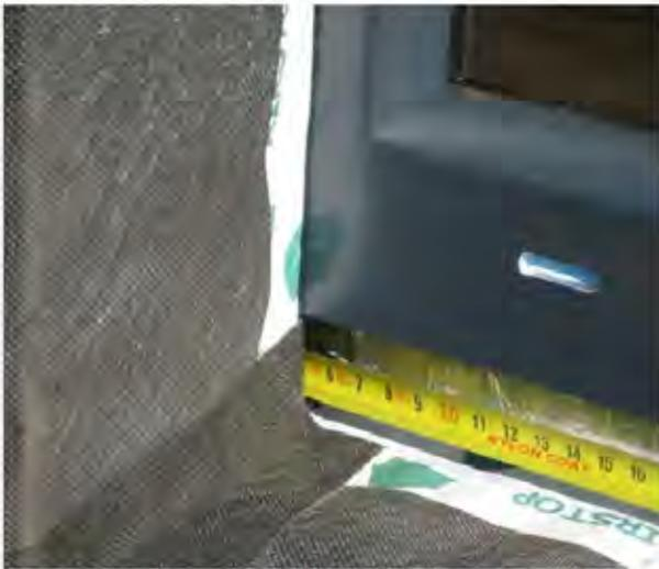
**Abbildung 34:** Ausführung der zweiten Dichtebene unter der Fensterbank mittels Folien. Da die Vorsatzschale nicht in die zweiten Dichtebene entwässert, sondern dahinter, ist darauf zu achten, dass der Eckbereich der Vorsatzschale gesondert verschlossen/ abgedichtet wird (siehe Pkt. 5.2). Das Gewerke Loch ist ebenfalls am besten mittels Dichtmasse zu verschließen.
