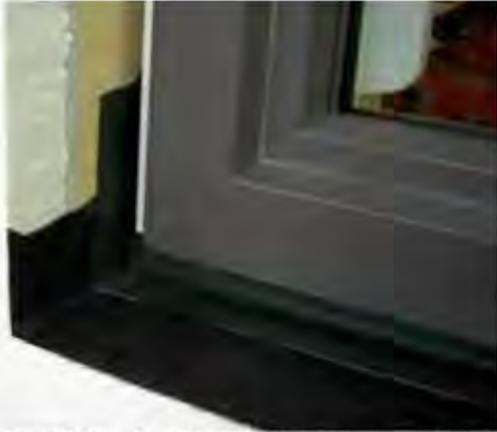
**Abbildung 30:** Zweite Dichtebene, welche wannenförmig an den Fensterrahmen mittels Folie und Klebeband angeschlossen wird. Seitlich in der Leibung besteht in diesem Fall die Möglichkeit die Folie ca. 6 cm hochzuziehen.
