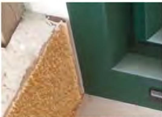
**Abbildung 22:** Fenster mit Vorsatzschale als Halbschale ausgeführt, Modell des Leibungsanschlusses
