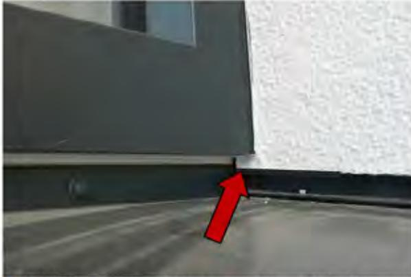
**Abbildung 20:** geschlossenes Gewerke Loch - vom Fassadenhersteller verschlossen
