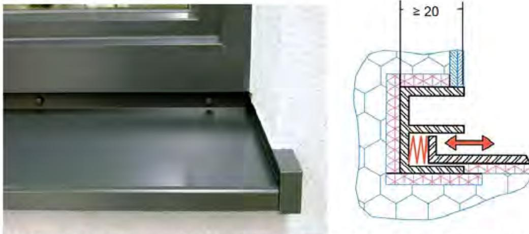
**Abbildung 25:** eingeputztes Gleitabschlussprofil mit federnder Wirkung - Beispiel und Prinzipskizze
