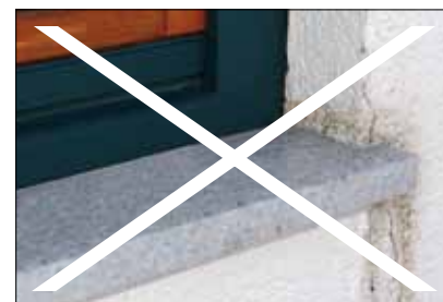
Falsch montierte Fensterbank
